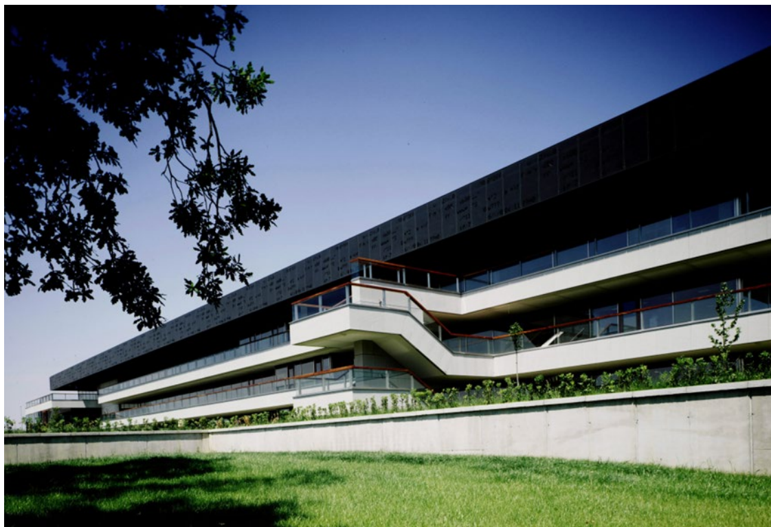
Instalaciones en el Parque Tecnológico de Bizkaia donde se incorporará el nuevo centro de I+D
